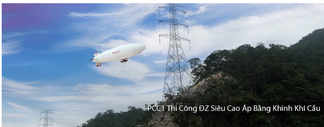
PCC 1 sử dụng Navi fly thi ĐZ 500kV Sơn La - Lai Châu
