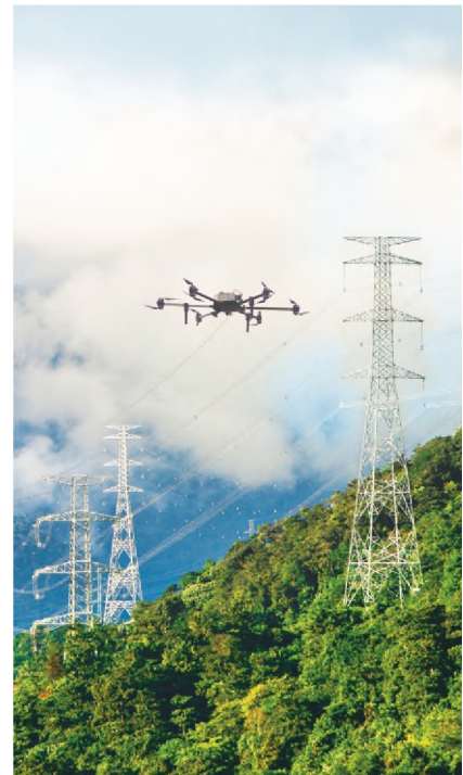
PCC 1 sử dụng Navi fly thi ĐZ 500kV Sơn La - Lai Châu
